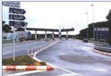
Surveillance de la construction d'une autoroute au Maroc
