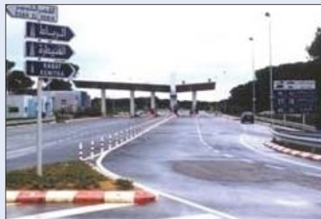
Surveillance de la construction d'une autoroute au Maroc
