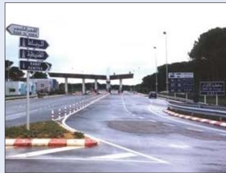
Surveillance de la construction d'une autoroute au Maroc
